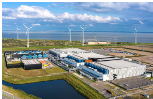
Figura 18: Data Center do Google em Eemshaven, Holanda
